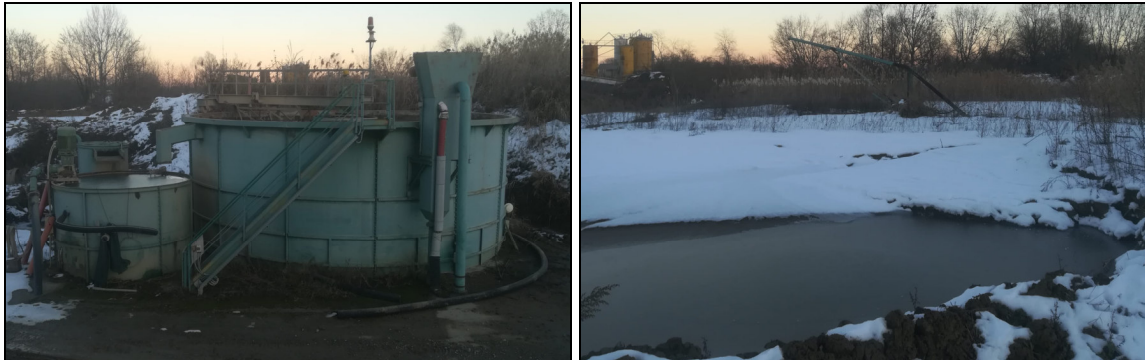
Fotografie del chiarificatore a sx e della vasca di raccolta a dx dell'impianto di trattamento NUOVA CAVE CERETTA srl
